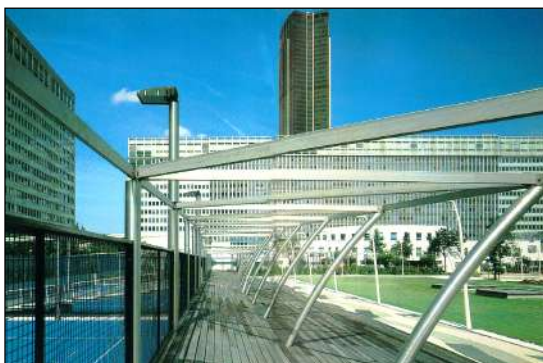
Il faut être sur le platelage pour surplomber et voir les tennis...
