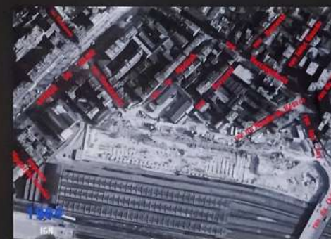
1964. Les travaux du secteur II de l'Opération Maine-Montparnasse sont engagés. Immeuble Mouchotte et tri postal mordent un peu plus sur l'îlot Vandamme. SHAP
