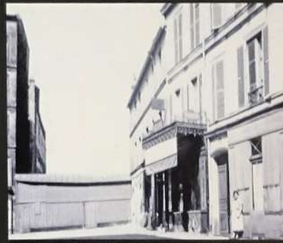
Le tronçon et son passage à niveau assuraient la continuité avec la rue du Cotentin. Il est obstrué par les ateliers ferroviaires.
