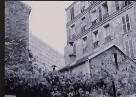
1969. En arrière du 15 rue du Moulin de Beurre. Face à la rénovation lourde de l'îlot Vandamme certains plaideront pour la sauvegarde du bâti ancien. D. BUTTER.
