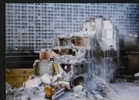
En fin d'année 1971, les derniers immeubles de la rue de Médéah, numérotés du 5 au 11, sont en passe de disparaître sous la pioche des démolisseurs. © GUYOT
