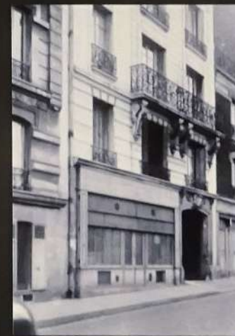
N° 67. Immeuble de six étages construit sans architecte. Le permis de construire a été délivré le 6 mars 1901.
