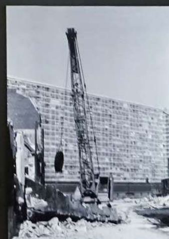
Fin 1971 : une boule de démolition aura raison des ultimes constructions de la rue de Perceval. © M. SUTTER
