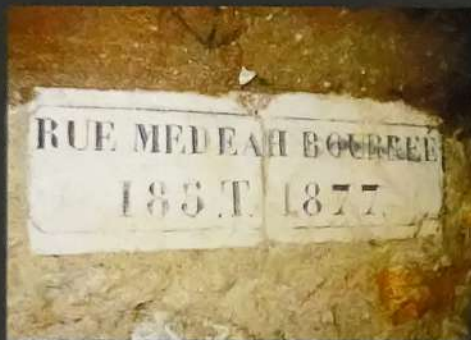
Inspection Générale des Carrières. Mention du bourrage de sécurité, numéro d'ordre, date et initiales de l'inspecteur général : Tournaire (Louis). AG. 200.44905
