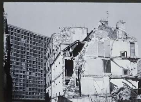
1971 : les immeubles des numéros 9 et 11 de la rue de Perceval sont en cours de démolition sur fond d'immeuble de la rue du Commandant Mouchotte. © M. SUTTER
