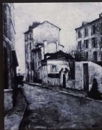
René Aberlenc : du 5 au 11 rue du Moulin de Beurre peu avant les restructurations de l'Îlot Vandamme.
