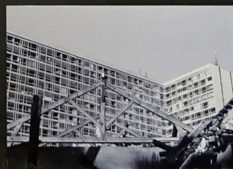
À l'angle de la rue de Médéah, le bâtiment du 29 rue Vandamme en cours de démolition, sur fond d'immeuble de la rue du Commandant Mouchotte. © GUYOT
